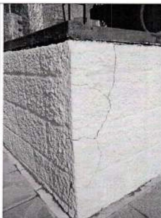
Фото 9. Трещины в отделке постамента паровоза.
