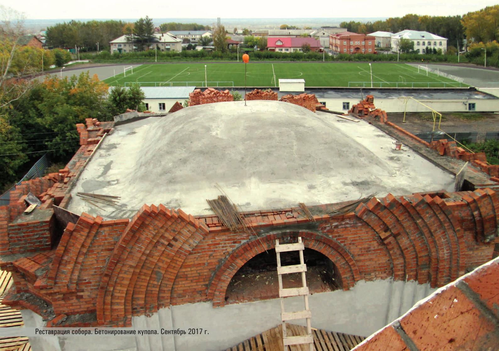
Реставрация собора. Бетонирование купола. Сентябрь 2017 г.
