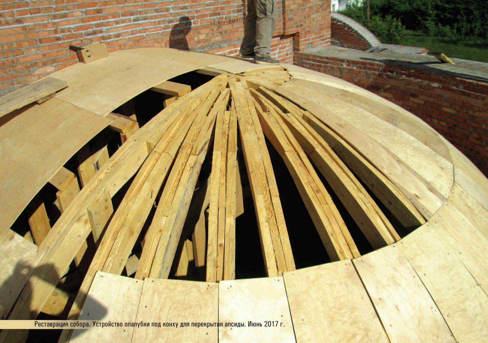
Реставрация собора. Устройство опалубки под конху для перекрытия апсиды. Июнь 2017 г.
