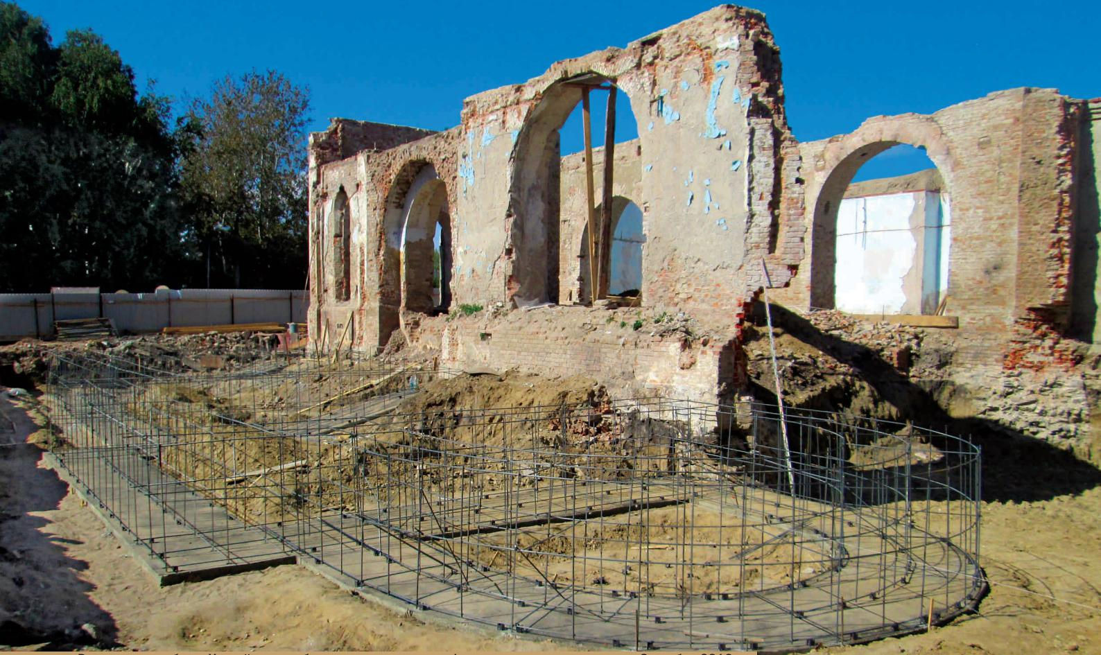
Реставрация собора. Устройство подбетонки и армирования фундамента южного придела. Сентябрь 2016 г.
